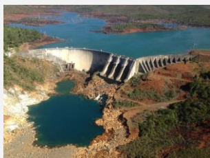
Aménagement hydroélectrique de Yaté
